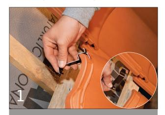
Der T-Schenkel wird zwischen Fuß und Kopf der beiden Tondachziegel am 4-Ziegel-Eck geführt.
