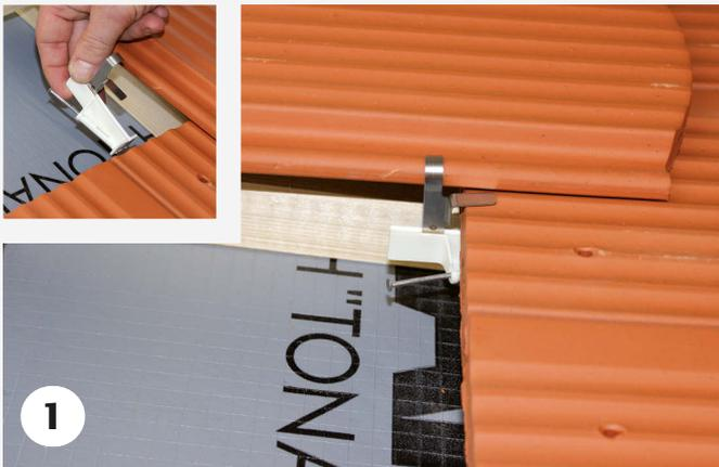
Die beiden Haken der Sturmklammer werden in der Seitenverfaltung und am Kopf der zwei zu befestigenden Ziegel eingehängt.
