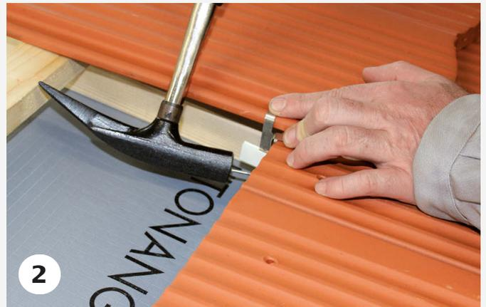
Der an der Sturmklammer herausstehende Nagel wird in die Traglattung eingeschlagen.
